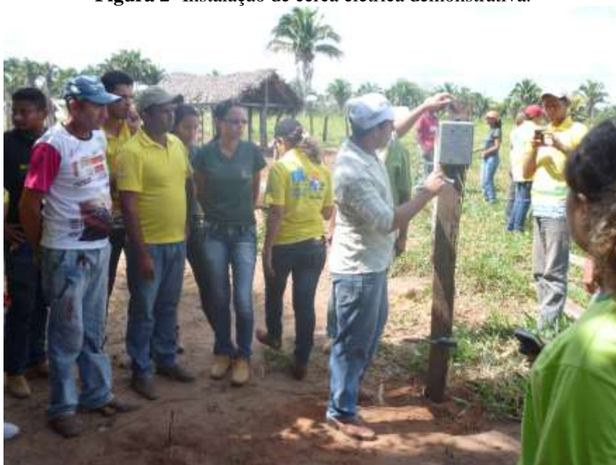
Figura 2- Instalação de cerca elétrica demonstrativa.
