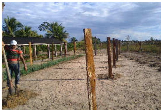
Figura 01: Construção da terceira estufa
