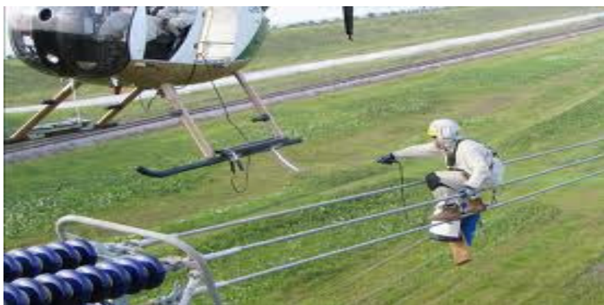
Figura 6 – Trabalhador em uma linha viva realizando a equalização Fonte: TA-LIGADAO, 2017.
