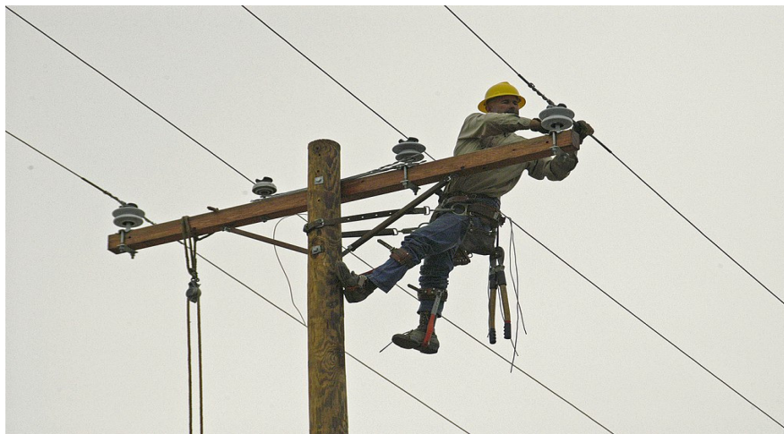
Figura 2 – Trabalhador eletricitista reparando uma linha danificada Fonte: Wikipédia, 2017.
