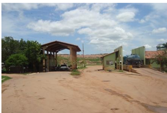
Figura 1 – Entrada do aterro controlado
