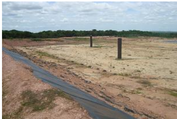
Figura 3- Futuras instalações do aterro sanitário de Teresina-PI
