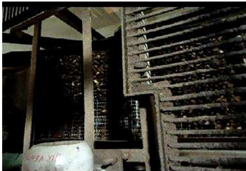
Figura 1- Máquina de peneiras vibratórias com falha de manutenção
