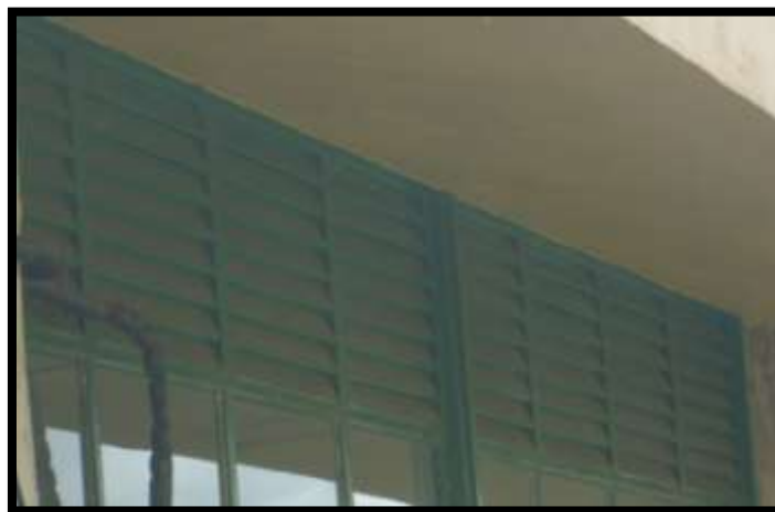
Figura 4 – Utilização de janelas tipo venezianas nos blocos do IFS - Campus Lagarto.
