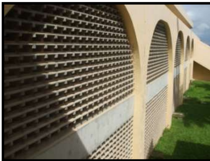
Figura 2 – Utilização de cobogós nos blocos do IFS - Campus Lagarto.
