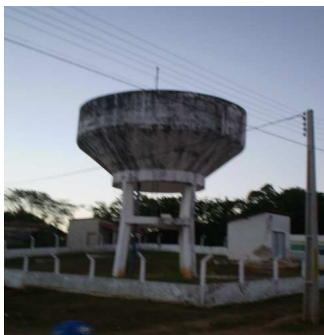
Figura 2(A) - Reservatório de armazenamento de água para ser distribuída para a população.
