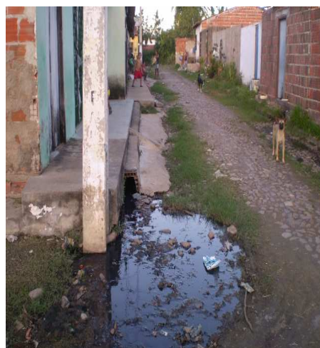
Figura 2(B) , esgoto a céu aberto disposto em nenhum tratamento na frente das residências.
