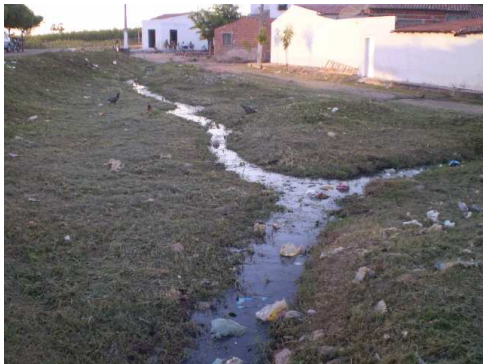
Figura 2(E) - os esgotos a céu aberto predominam.
