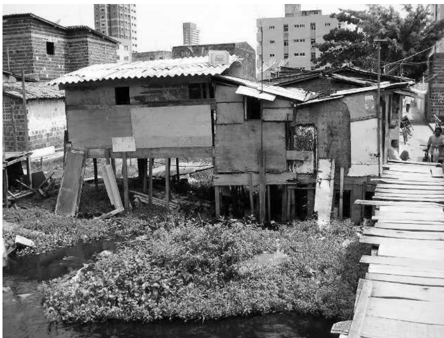
Figura 4 – Presença de moradias no leito do rio Jaguaribe, favela São José.
