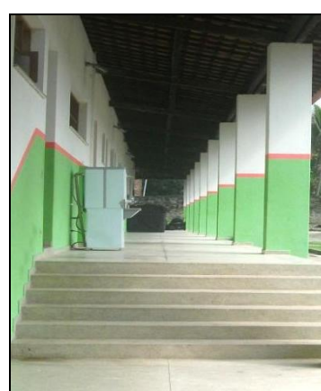
Figura 11: Acesso ao vestiário.
