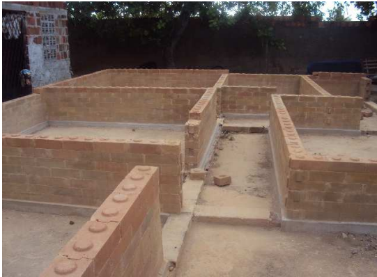
Figura 1. Casa sendo construída em solo-cimento Fonte: Pesquisa de Campo, 2012
