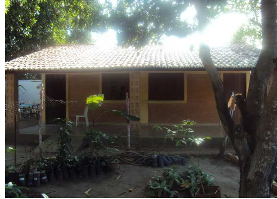
Figura 1. Casa construída em solo-cimento Fonte: Pesquisa de Campo, 2012
