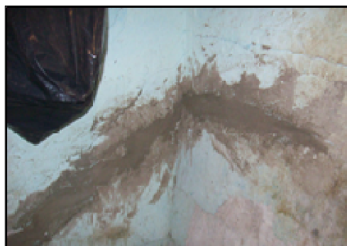
Figura 6 - Reparo na parede
