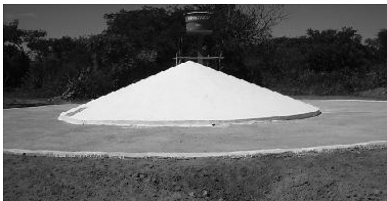
Figura 4 - Cisterna calçadão, chapéu de Padre Cícero
