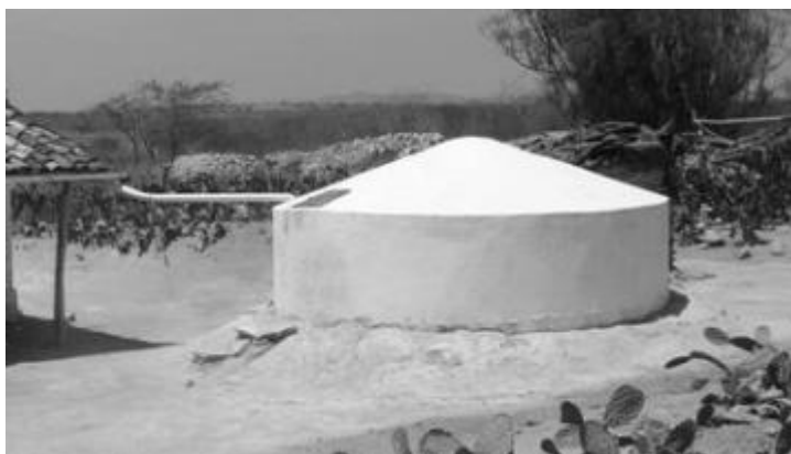
Figura 2 – Exemplo de uma cisterna de placas
