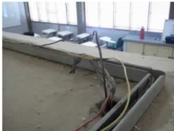
Figura 04 – Fiação exposta.
