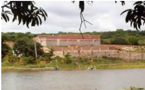
Figura 2: Construções irregulares. Fonte: Silva (2009)
