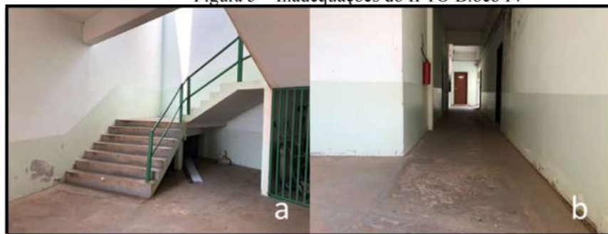
a- Circulação vertical; b- piso com desníveis
