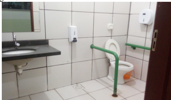
Figura 5 - Banheiro PcD Masculino Bloco I.
