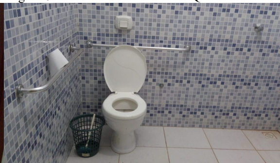
Figura 6 - Banheiro PcD Feminino Quadra.
