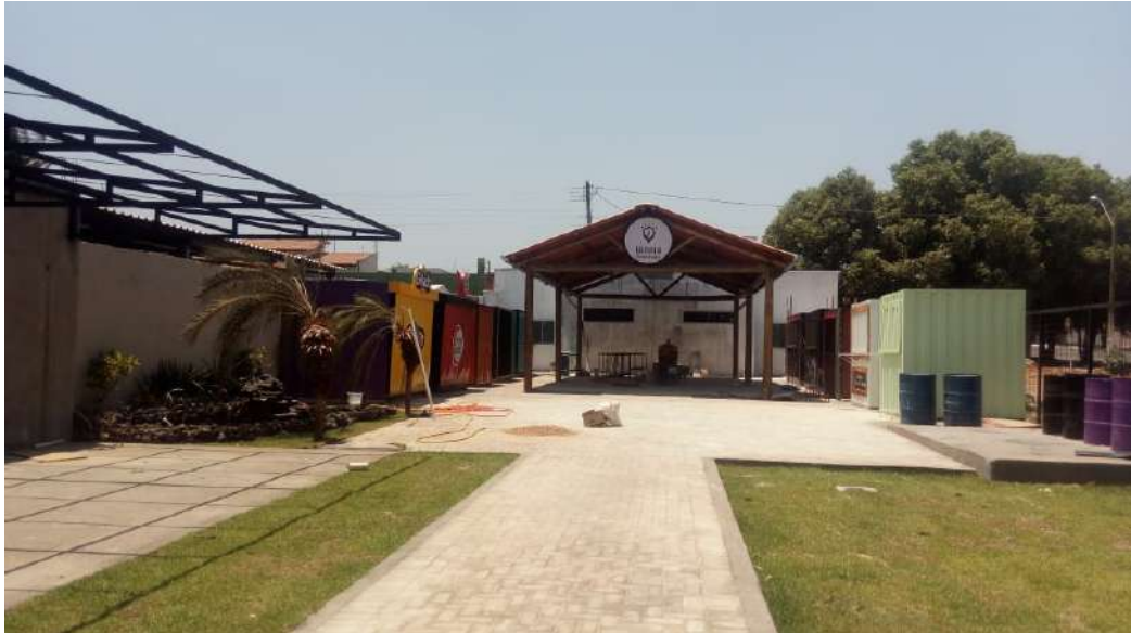
Figura 3 -. Praça de Alimentação que utiliza o contêiner como material construtivo, em fase final.
