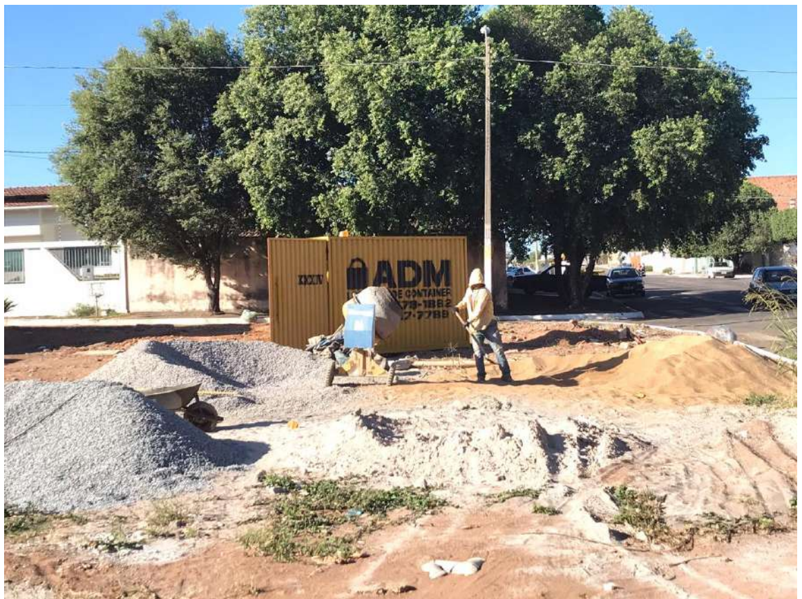
Figura 1 - O contêiner usado como armazenamento de materiais no canteiro de obra.
