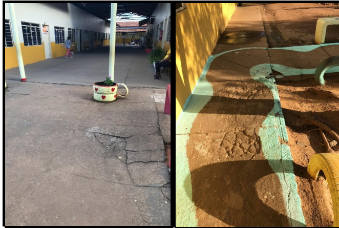
Figura 3-Hall de entrada e calçadas internas
