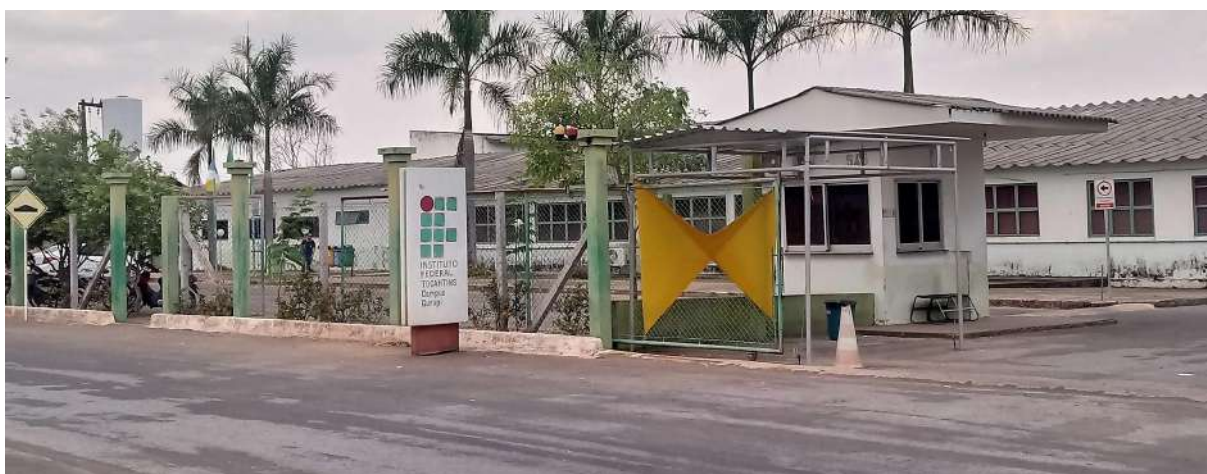
Figura 1 - Vista da entrada principal do Instituto Federal do Tocantins - Campus Gurupi .
