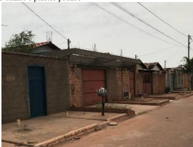
Figura 7 – Edificação invadindo o passeio público
