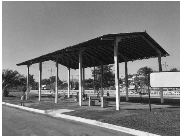
Figura 3 – Estrutura pré-moldada de concreto em uma academia pública na avenida Beira Rio.
