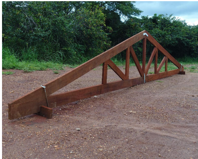
Figura 1 – Treliça do tipo Howe construída.
