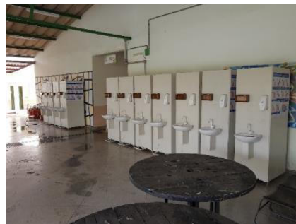
Figura 7 – Teste de Funcionamento e Estanqueidade.
