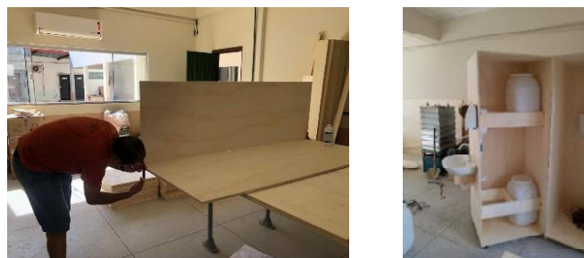
Figura 3 – Montagem da Estrutura das Estações de Higienização.
