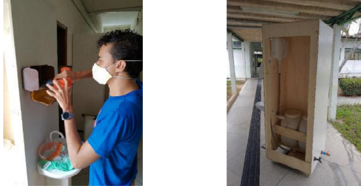
Figura 6 – Confecção das Instalações Hidráulicas e Sanitárias.
