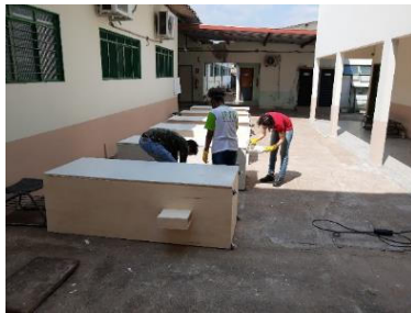
Figura 4 – Pintura das Estruturas das Estações de Higienização.
