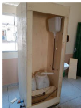
Figura 5 – Confeção das Instalações Hidráulicas e Sanitárias.
