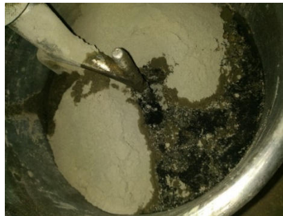
Fig. 2 –Mistura dos agregados
