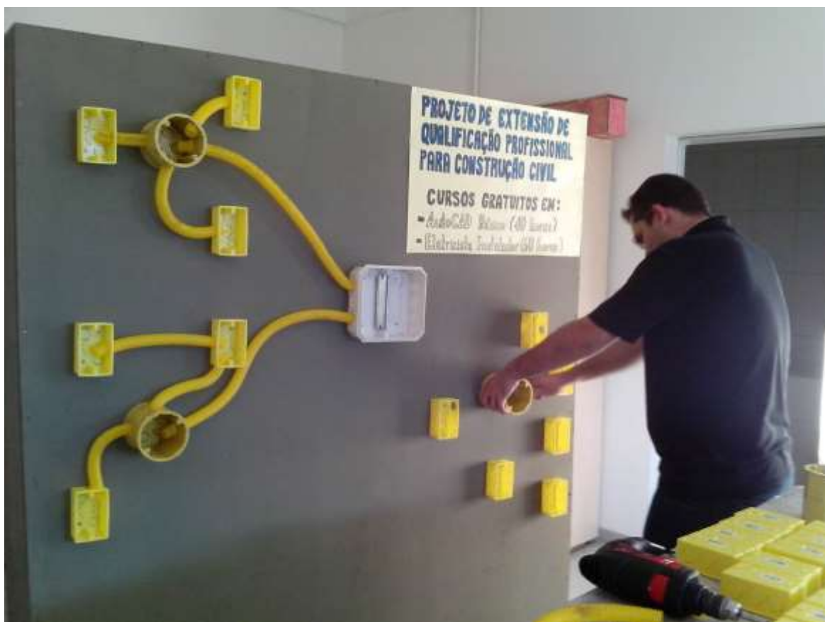
Figura 2 – Montagem das bancadas de práticas de instalações elétricas.
