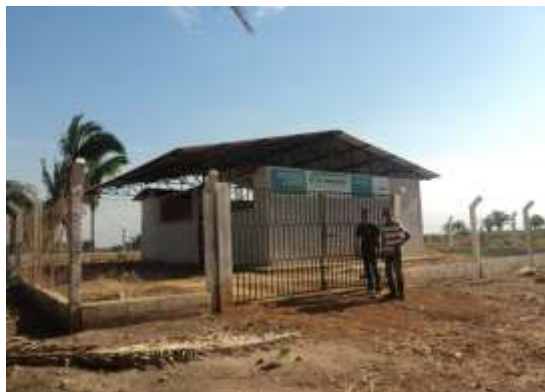
Figura 02 – Unidade de recebimento de embalagens (posto), município de Tocantinópolis
