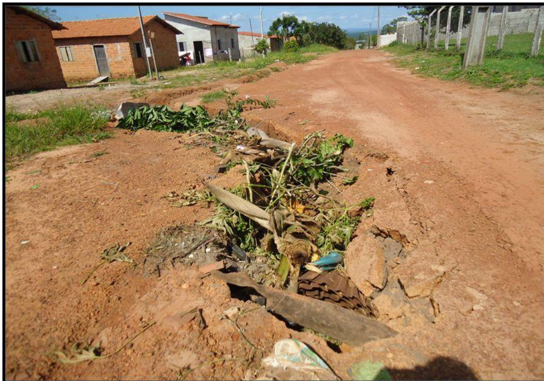
Figura 3 – Contensão de erosão na Rua Faizão, com uso de galhadas e outros resíduos. Fonte: Duarte, Rita de Cassia Ferreira, 23/11/13.
