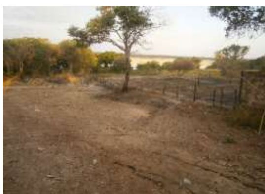
Figura 05: Área de APP iniciando o processo de erosão Fonte: Autores do Trabalho, 2014.
