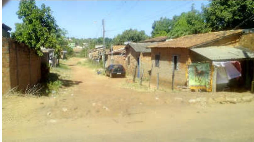
Figura 02: Aspecto de rua e das moradias no Bairro Cimba(Araguaína-TO)
