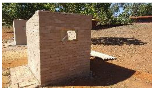
Figura 29: protótipo de tijolo de solo cimento desenvolvido pelo grupo. Fonte: grupo TEMAS, 2016.
