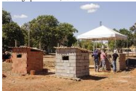
Figura 21: protótipo de alvenaria de concreto em construção. Fonte: grupo TEMAS, 2016.
