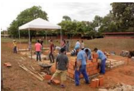
Figura 18: elevação do protótipo de tijolo cerâmico. Fonte: grupo TEMAS, 2016.
