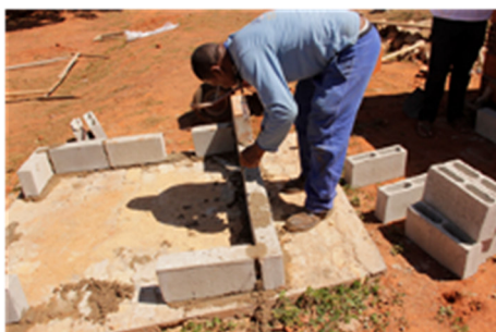
Figura 20: primeira fiada do protótipo de alvenaria de concreto. Fonte: grupo TEMAS, 2016.
