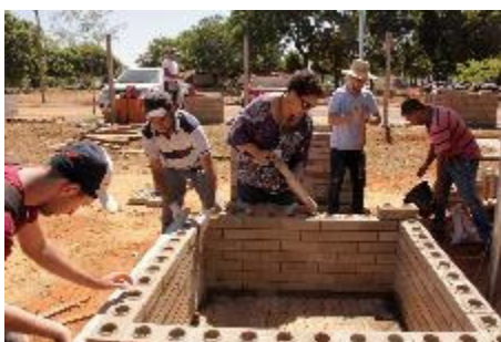
Figura 28: protótipo de tijolo de solo cimento desenvolvido pelo grupo. Fonte: grupo TEMAS, 2016.
