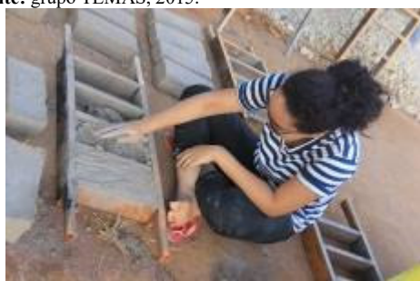
Figura 13: colocação da massa nas formas. Fonte: grupo TEMAS, 2015.
