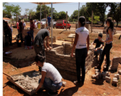
Figura 25: protótipo de alvenaria de concreto finalizado. Fonte: grupo TEMAS, 2016.
