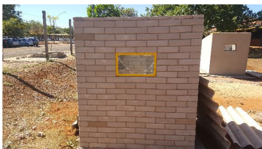
Figura 30: fachada oeste do protótipo de solo-cimento. Fonte: grupo TEMAS, 2016.
