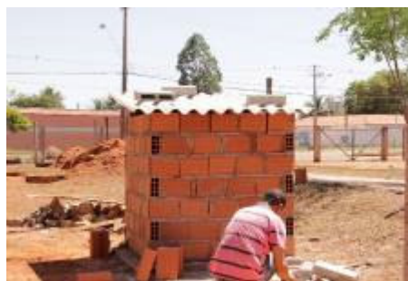
Figura 19: elevação do protótipo de tijolo cerâmico. Fonte: grupo TEMAS, 2016.
