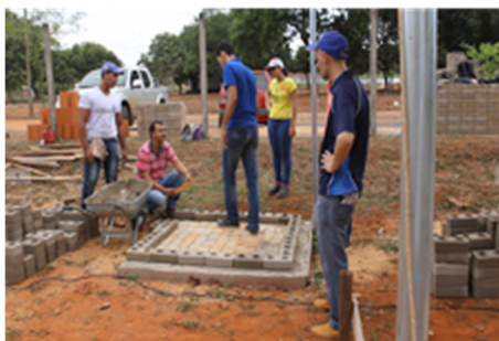
Figura 26: protótipo de tijolo ecológico – primeira fiada. Fonte: grupo TEMAS, 2016.
