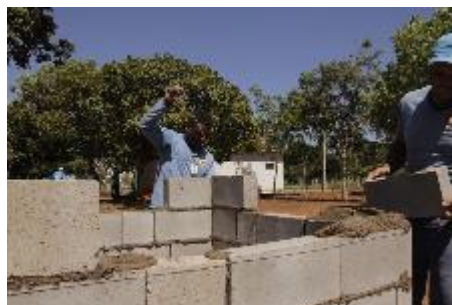
Figura 21: protótipo de alvenaria de concreto em construção. Fonte: grupo TEMAS, 2016.
