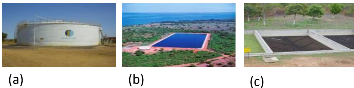
Figura 3 - Tratamento Biológico da ETE: (a) Reator UASB, (b) lagoa facultativa e (c) leitos de secagem.
