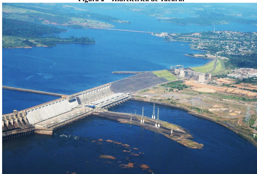
Figura 2 – Hidrelétrica de Tucuruí
