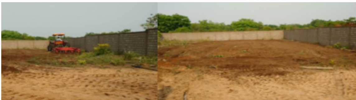
Figura 2 – Limpeza da área: Escola Municipal Vanor da Costa Parreão
