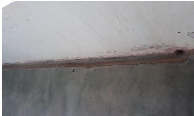
Figura 11-Corredor de acesso as salas
