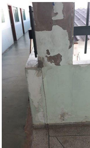
Figura 12-Pilar com rachadura
