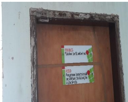
Figura 06- Esquadria deteriorada
