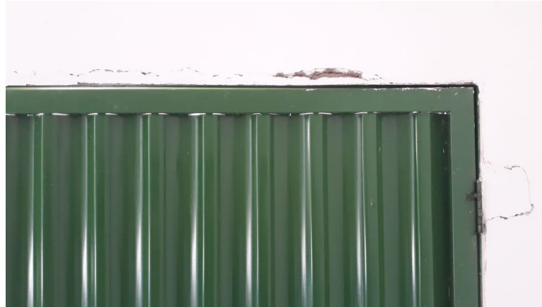
Figura 15- Porta do laboratório de Construção Civil
