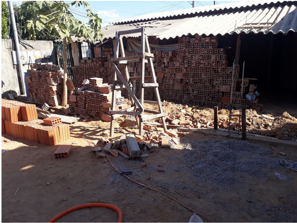
Figura 02- Obra residencial com demolição prévia, onde a maior parte dos resíduos encontrados foram componentes cerâmicos da construção demolida.
