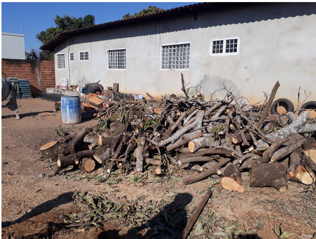
Figura 03- Canteiro de Obras de uma construção residencial, onde os resíduos encontrados era galhos e troncos de árvores, devido a limpeza do terreno, fase de preparo do lote, que antecede a construção.
