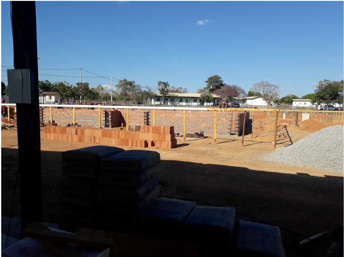
Figura 01- Canteiro de Obras de uma Construção Pública.
