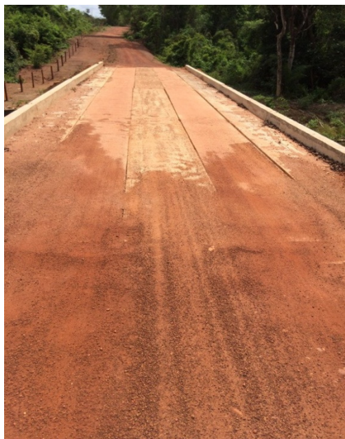
Figura 8. Via única, a qual os veículos transitavam enquanto a obra estava em andamento
