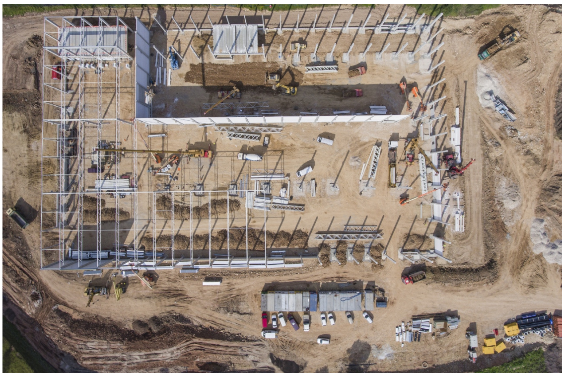
Imagem 6 – Canteiro de Obra
